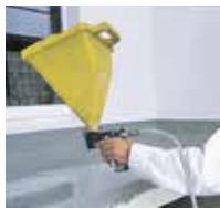
10 ... Triflex Micro Chips einblasen.
