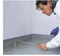
8 Die Versiegelung Triflex Cryl Finish 205 erst an den Details, ...
