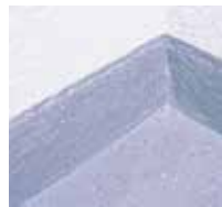
11 Der Balkon ist innerhalb eines Tages fertig.
