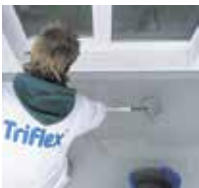
9 ... dann auf die Fläche aufbringen und ...
