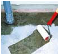
1 Wandanschluss und Fläche grundieren.
