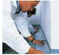
3 Triflex Spezialvlies blasenfrei einlegen und ...
