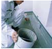
2 Anschlüsse mit Triflex ProDetail vorlegen.
