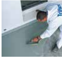
6 ... mit einer Kelle aufziehen und ...
