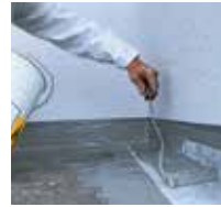
4 ... mit Triflex ProDetail satt nachlegen.
